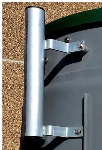
Permet de positionner la potence pour l'entretien des postes, (démontage des pompes).
